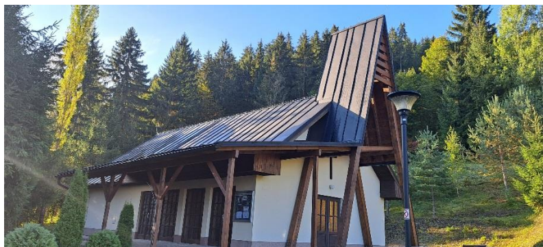
Vybudovaný prístrešok na dome smútku
